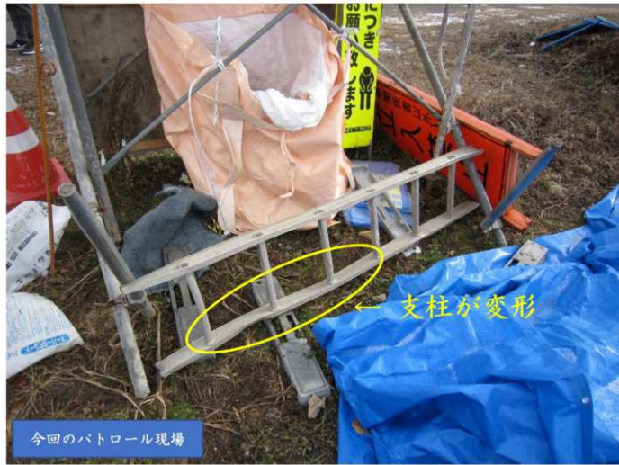
はしごの支柱部分が変形
