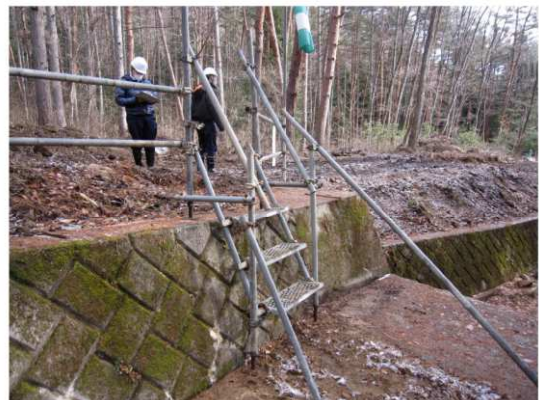
昇降足場設置例 (良好)：今回のパトロール現場
