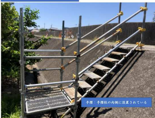
昇降階段設置例（従来工法：良好）
