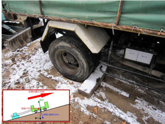
輪止めの設置 (栈木はNG) : 今回のパトロール現場
