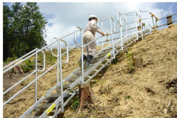
昇降階段置例（アルミ製傾斜自在階段：良好）
