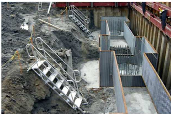
昇降足場設置例 (良好)
