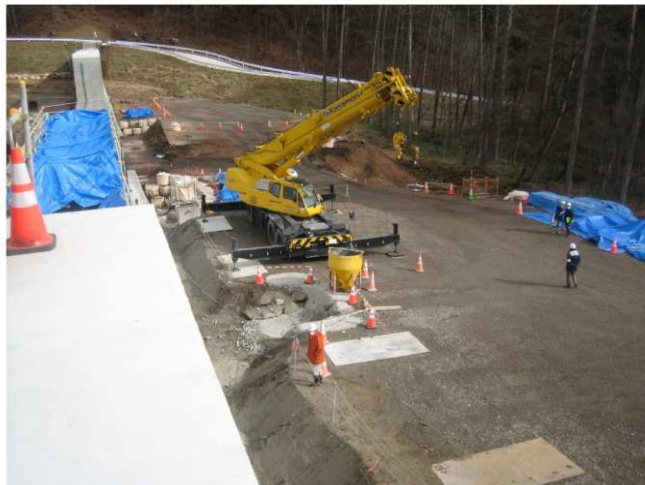
コンクリート打設用ラフタークレーン
