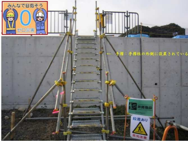
作業場への昇降階段（今回のパトロール現場）
