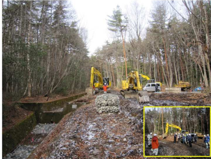
多くの建設機械が稼動（今回のパトロール現場）
